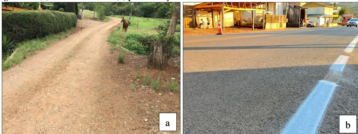
Figura 49 – (a) estrada de terra e (b) pavimentação asfáltica.
