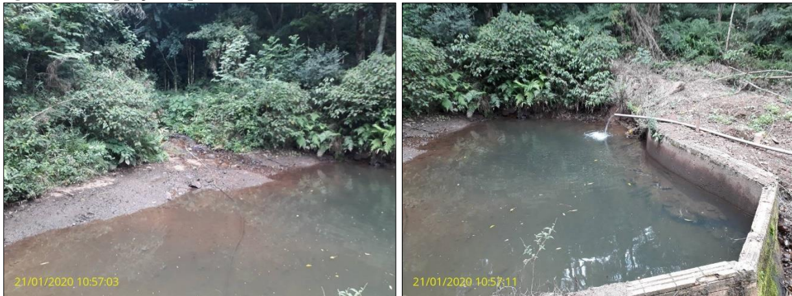
Figura 43 – Captação superficial - Rio Taboão.
