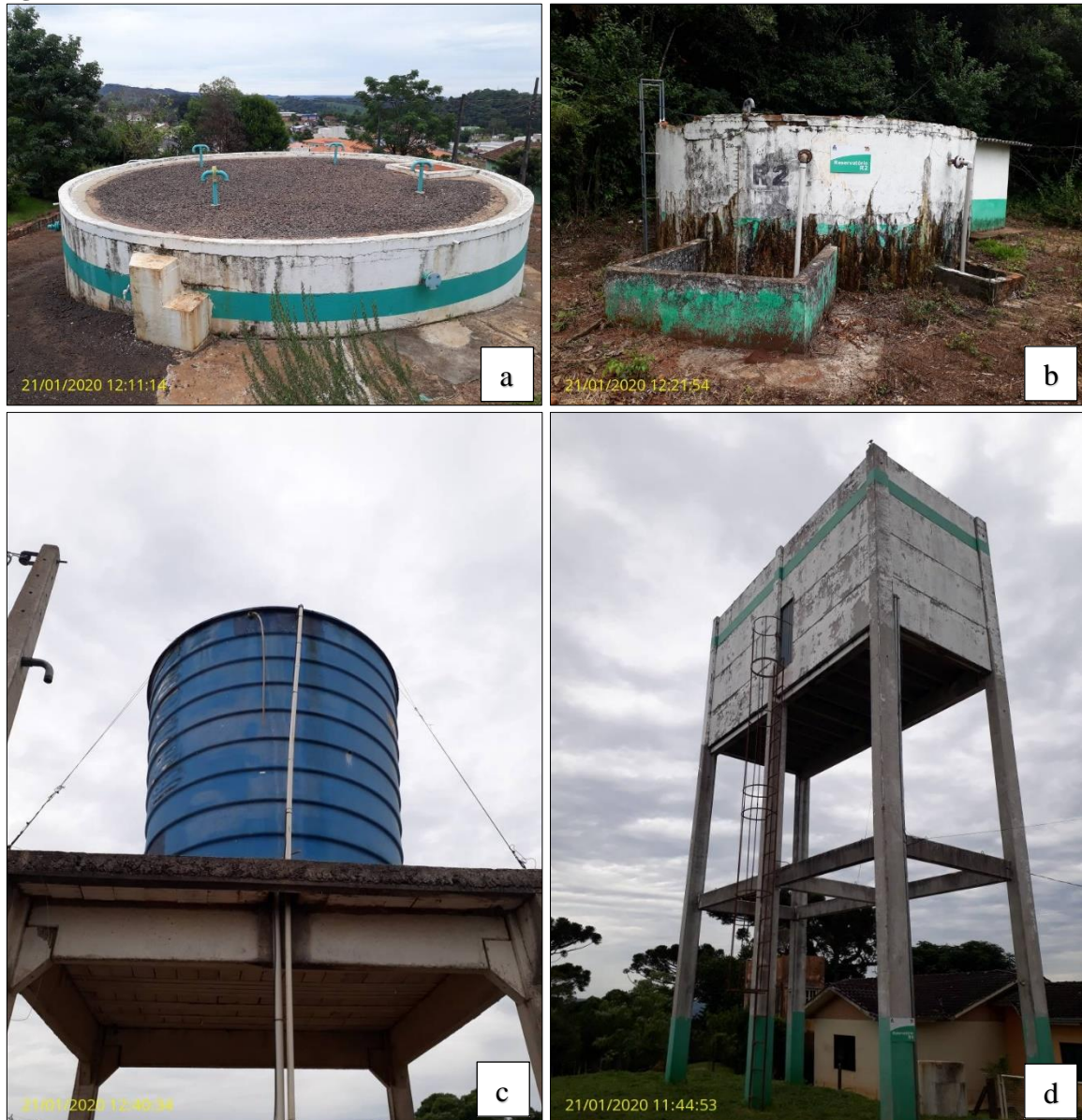
Figura 45 – Reservatórios: a) R1; b) R2; c) R3; d) R4.
