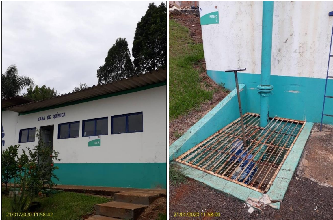
Figura 44 – Estação de Tratamento de Água - ETA.
