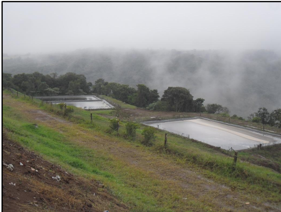
Figura 22: Lagoas de tratamento do lixiviado
